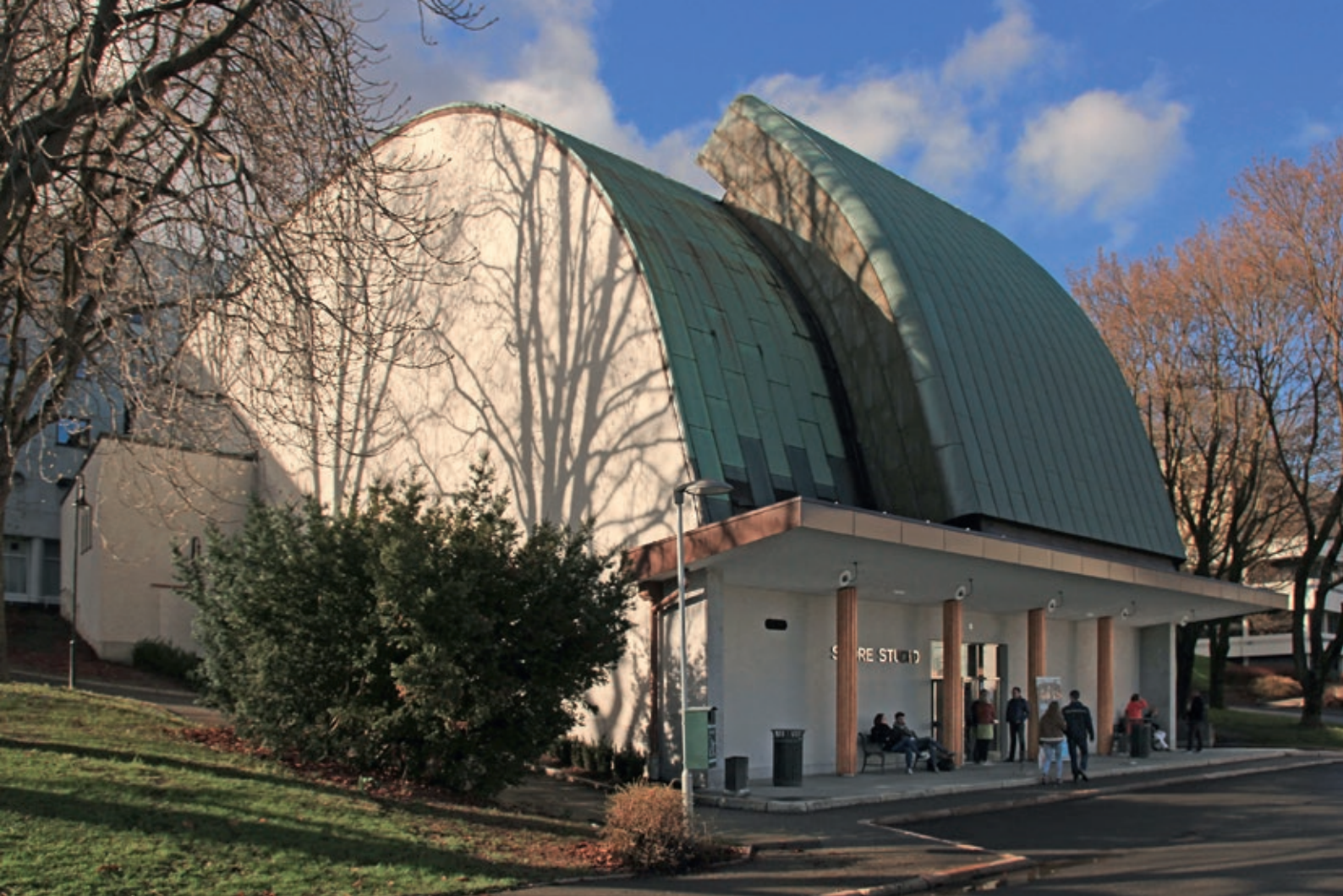
Store studio på Marientlyst i Oslo ble fredet i 2018. Det er tegnet av Nils Holter og ble bygget 1938–1950. Mineralittfasadene ble rehabilitert i 2014, etter nærmere 80 år med lite vedlikeholdsbehov
